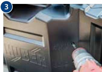
3 Überlaufbohrung setzen (gemäß Ballastierungsvorgabe*).
