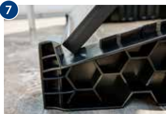
7 PV-Modul in die Adapter-Raster einlegen und einschwenken.
