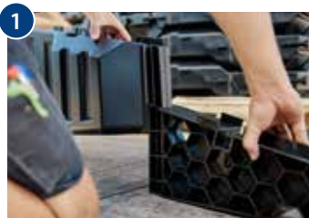
1 Tank-Modul mit Adaptern (links/rechts) verbinden.
