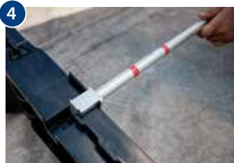
4 Länge des PV-Moduls mit der Montagestange abnehmen und Tank entsprechend positionieren.
