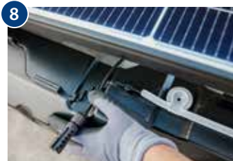
8 Kabel des PV-Moduls durch die Kabelführung legen und einklicken.
