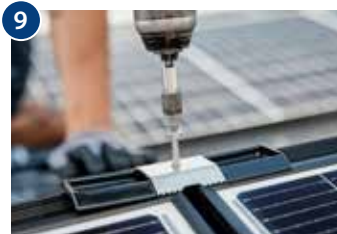
9 PV-Module oben mit der Klemme fixieren. Mit Drehmoment (12 Nm) anziehen.
