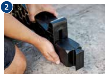
2 Direktverbinder für weitere Modulreihen anbringen (Zwischenstück eng oder Zwischenstück Wartungsgang).
